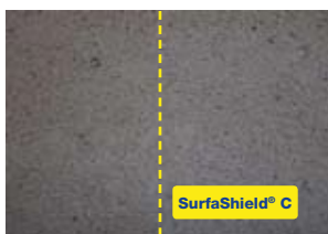
Superficie di cemento trattata per metà con SurfaShield C
